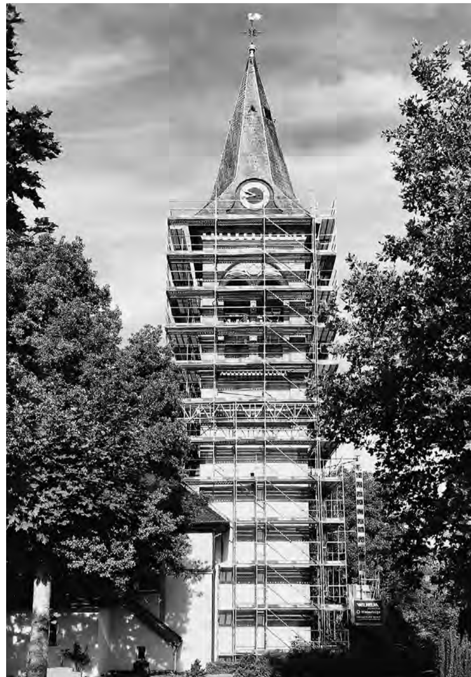
Ecklösungen wie bei der Einrüstung eines Kirchturms können mit dem AGS von Layher nicht nur passgenau umgesetzt, sondern auch vorlaufend montiert werden. FOTO: LAYHER
