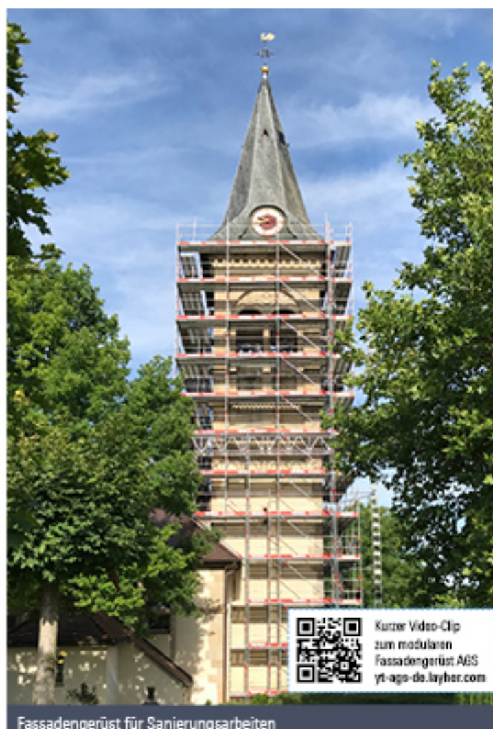
Fassadengerüst für Sanierungsarbeiten
