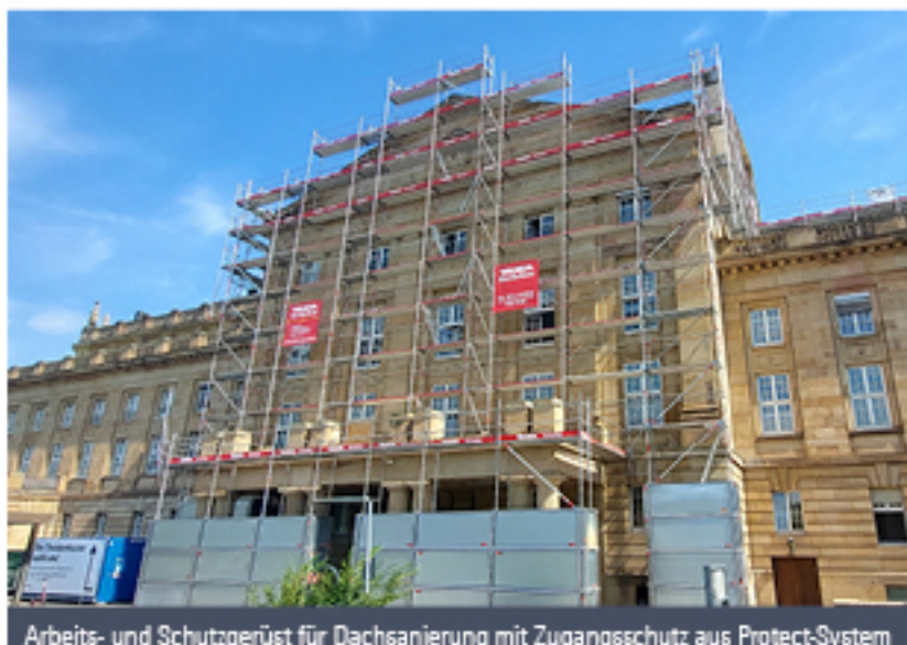
Arbeits- und Schutzgerüst für Dachsanierung mit Zugangsschutz aus Protect-System
